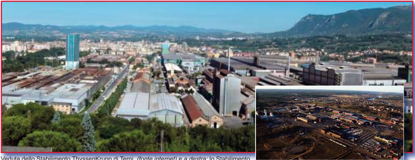
Veduta dello Stabilimento ThyssenKrupp di Terni (fonte internet) e a destra: lo Stabilimento Outokumpu di Avesta (galleria fotografica Outokumpu)
